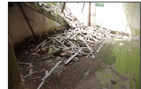
Etat de la toiture Source : Les Snats 2020
