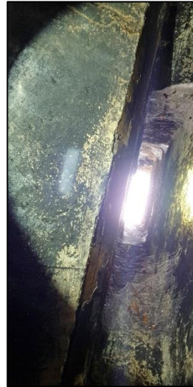
Inspection du conduit de cheminée Source : Les Snats 2020
