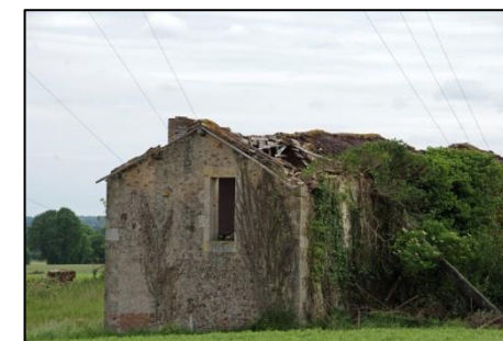
Bâtiment en ruine de la Naulerie, côté Sud-Ouest Source : Les Snats 2020
