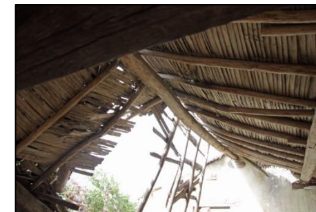
Etat de la toiture Source : Les Snats 2020
