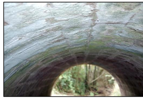
Inspection du tablier Source : Les Snats 2020
