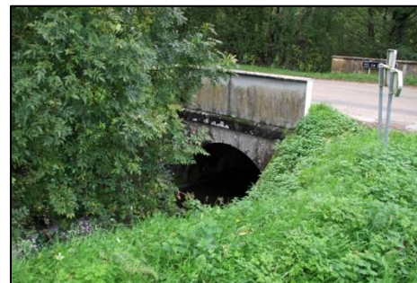
Pont sur le Chilleau (RD121 X RD176) Source : Les Snats 2020
